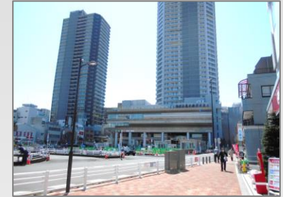
周辺道路等整備事業 （国分寺駅北口交通広場）
