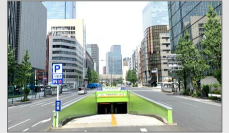
東京都八重洲駐車場
