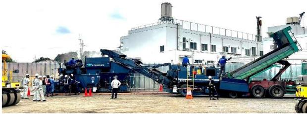
写真-5 施工状況（二層同時施工）
