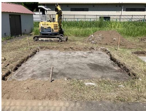
写真-2 掘削状況 (薄6の場合)
