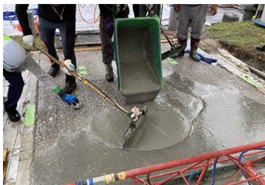
写真-9 敷き均し状況(薄6の場合)
