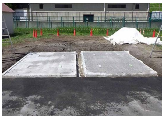
写真-4 切削完了状況 (薄4 薄3の場合)
