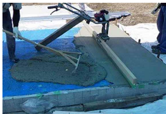
写真-6 敷き均し状況 (薄3の場合)
