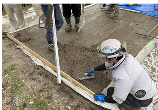
写真-8 敷き均し状況 (薄5の場合)
