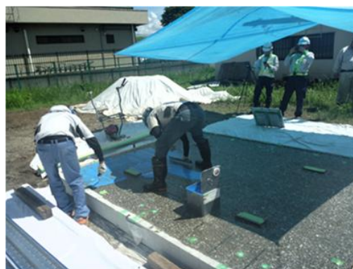
写真-5 接着剤塗布 (薄3の場合)
