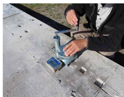
写真-9 接着強度試験の状況
