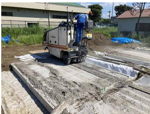
写真-3 切削状況 (薄5 薄6の場合)
