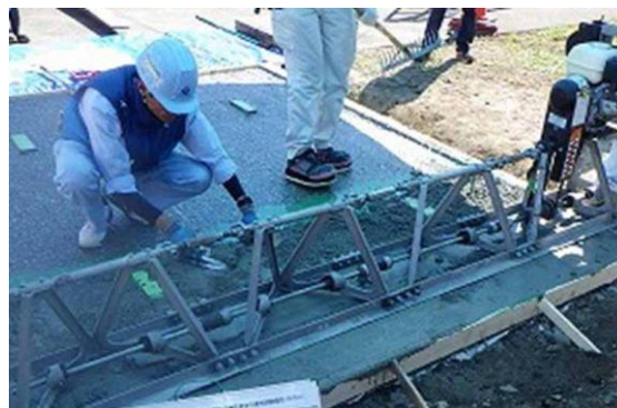
写真-7 敷き均し状況 (薄4の場合)
