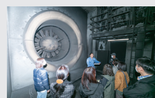
▲ 環2築地虎ノ門トンネル見学ツアー
