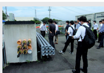
▲ 無電柱化の技術講習会 (電線共同溝整備講習会)
