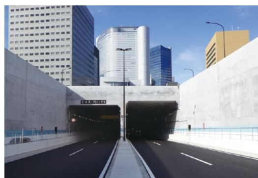
環状二号線築地虎ノ門トンネル
