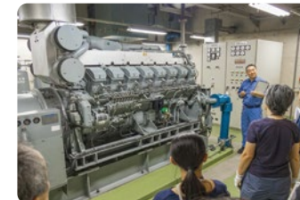
停電に備えて設置されている非常用発電設 備は、船舶規模のディーゼルエンジンを使用。 すぐ起動できるように常に温まっています。
