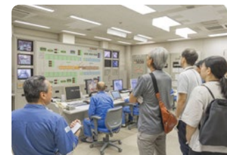
トンネル内に設置された監視カメラで24時 間365日監視
