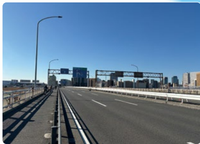
六郷橋 大田区東六郷と神奈川県川崎市川崎区本町との境の多摩川、国道15号(第一京浜国道)に架かる橋長443.7m、幅員34.4mの橋。現在の橋は六郷橋の拡幅のために架け替えられたもので、第3期の工事が平成9年(1997)に完了した。
