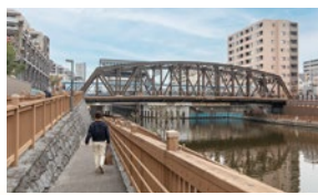
小松橋と扇橋閘門横の川岸路 （小名木川しおのみち）
