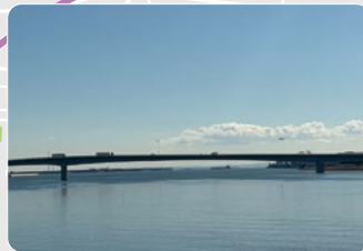
多摩川スカイブリッジ
