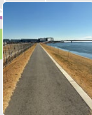
整備された道
