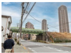
亀戸から越中島へ向かう貨物線の架道橋
