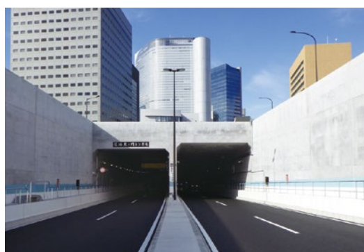
環状二号線築地虎ノ門トンネル
