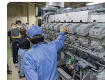
停電に備えて設置されている非常用発電設備は、船舶規模のディーゼルエンジンを使用。すぐに起動できるようにプレヒーティングされています。
