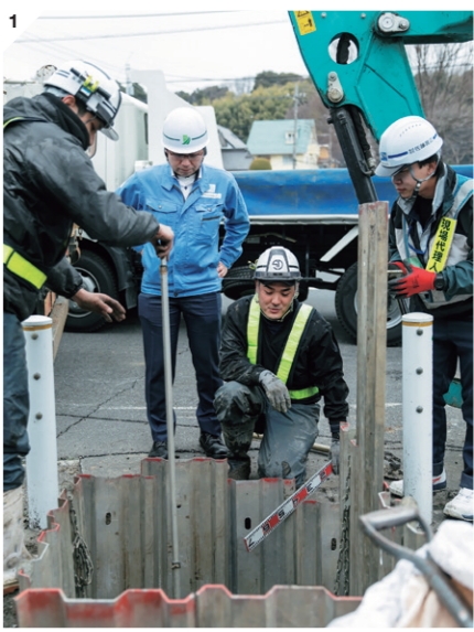
1.電線共同溝を設置するために開けた穴を確認中。施工業者の方と一緒に、丁寧にチェック。2.工事状況を見守る高橋さん。通行者の方の安全に気を配るのも大事な仕事。3.作業に欠かせない綿密な設計図。その分厚さは、なんと5cm以上!
