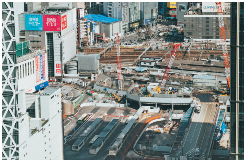
小田急百貨店が解体されたため、今は東口まで見渡せる。二層になった駅前広場の中央を縦断する道路は、小田急跡地の構台につながる工事用仮設スロープ。(工学院大学新宿キャンパスより撮影)
