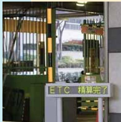
社会実験に参加いただいているモニター車はコンピュータで「ETC 精算完了」が表示されてゲートが開きます。入出庫を管理しています。
