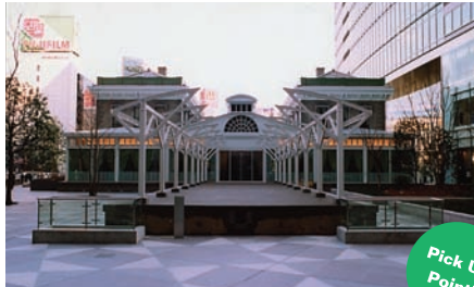
プラトホーム側より見た駅舎
