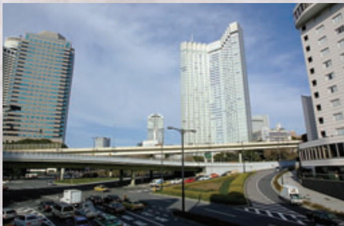
首都高速道路4号線が開通した直後、1964年の赤坂見附と現在の赤坂見附交差点付近。
