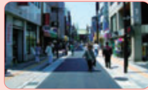
地中化施工後
