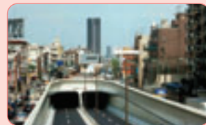
環状八号線井荻トンネル
