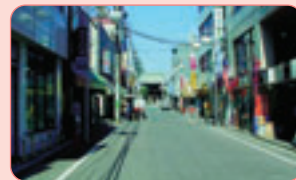
地中化施工前
