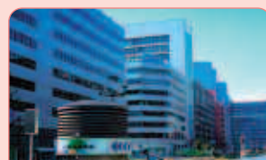
東京都八重洲駐車場
