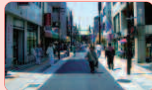
地中化施工後
