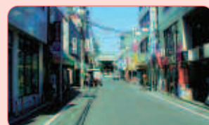
地中化施工前
