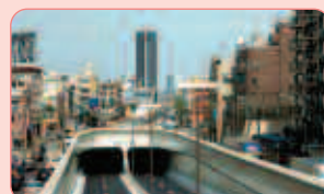
環状八号線井荻トンネル
