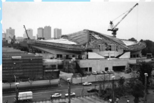
建設途中の東京体育館
