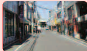
無電柱化施工前
