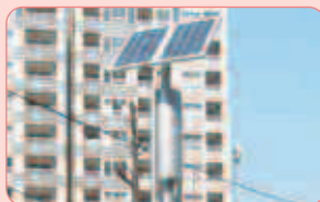
太陽光発電設備の設置
