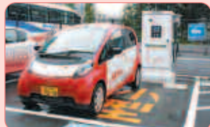
電気自動車充電設備の設置
