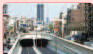
環状八号線井荻トンネル
