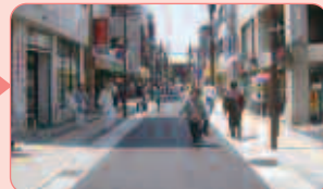
無電柱化施工後
