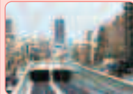
環状八号線井荻トンネル
