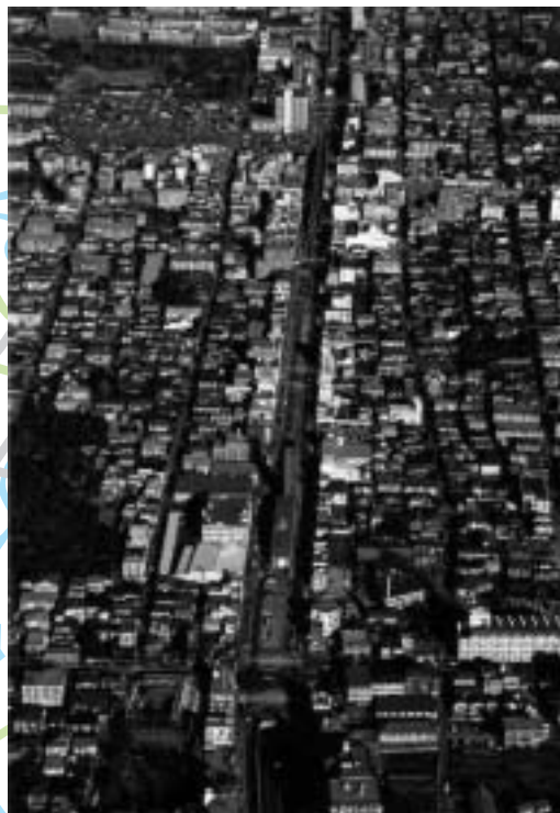
環状8号線が西武新宿線をオーバーパスする井荻立体交差が完成して、踏切による交通渋滞が緩和された
