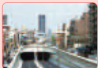
環状八号線井荻トンネル
