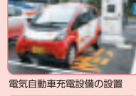
電気自動車充電設備の設置
