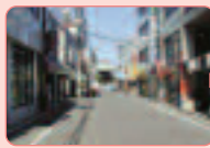
無電柱化施工前
