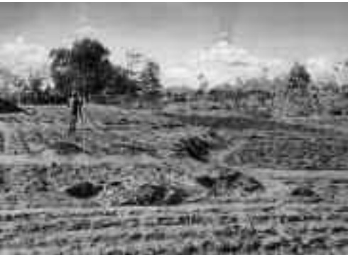
淀橋浄水場建設前の用地の測量風景 (明治24年頃)
