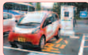
電気自動車充電設備の設置
