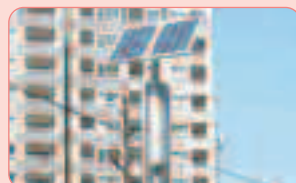
太陽光発電設備の設置
