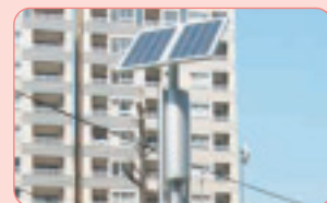
太陽光発電設備の設置
