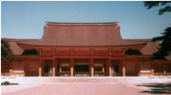
竣工成ったばかりの明治神宮新社殿。 銅板瓦の色に新しさがはっきりと伺える(昭和33年11月1日) 写真提供／明治神宮
