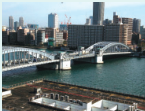
形式はシカゴ型双葉跳開橋、センタースパンに跳開橋、その両側はタイドアーチ橋。橋長246m、幅員26.6m、中央部が「ハ」の字に開く可動橋。
