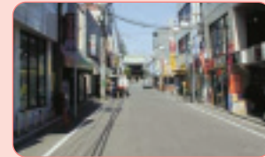
無電柱化施工前
