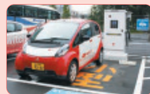
電気自動車充電設備の設置
