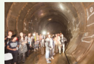
壁面に書かれているのは、補修のためヒビ割れや剥離などを示すためのマークだそうです。
