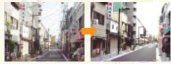
無電柱化施工前
