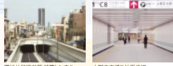
環状八号線井坂橋馬場トンネル
