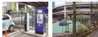
電気自動車充電インフラ(急速充電器 200V充電スタンド) 【六本木駐車場】
