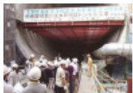
首都高速中央環状線井狹トンネル工事現場
