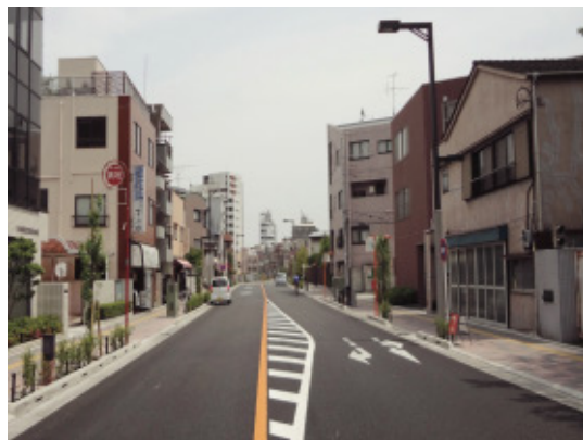
電線類地中化整備後
