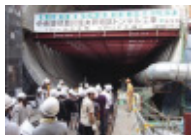
首都高速中央環状川線トンネル工事現場
