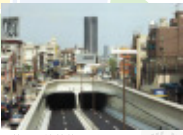
環状八号線井狹トンネル
