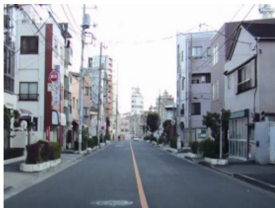
電線類地中化整備前
