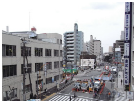
電線類地中化整備前
