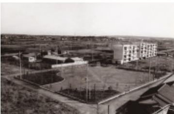
西多摩地方事務所(現・東京都青梅合同庁舎)屋上から北東方面を臨む(手前は白はけ公園)
