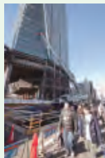
幅員が40mになる道路整備も着々と進んでいました。
