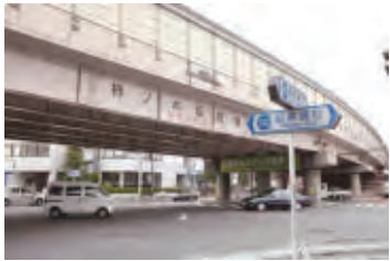
柿ノ木坂陸橋 平成25年
