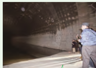
シールド工法で掘られたものです。
