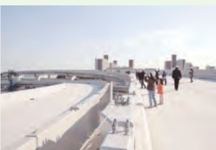
完成間近の大井ジャンクション。左側が湾岸線千葉方面へ、右側が湾岸線羽田方面につながる。
