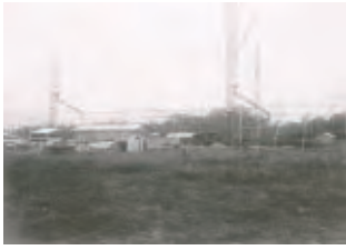
府立高校建設予定地 昭和5年頃
