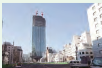
立体道路制度を活用して道路の上下に建築中の超高層複合タワー。地上52階建て、高さ247mの都内で2番目の高さになる予定。名称は「虎ノ門ヒルズ」に決まったそうです。
