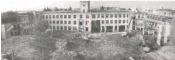
都立大学の解体工事 平成3年
