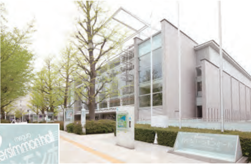
めぐろパーシモンホール
