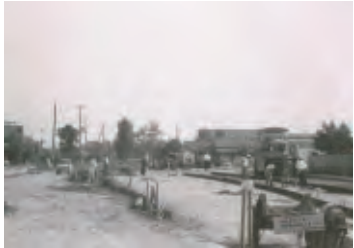
環七通りの工事 昭和38年
