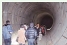
縦穴から調節池まではトンネルで150mほど。壁面に書かれた記号は調査箇所を示すマークです。
