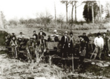
杉並村高円寺原の道路工事(高円寺南3-58-4付近)
