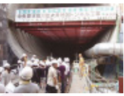
首都高速中央環状線川線トンネル工事現場
