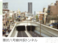
環状八号線井狹トンネル
