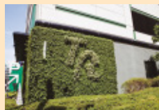
駐車場外壁は自動灌水システムを備えた壁面緑化
