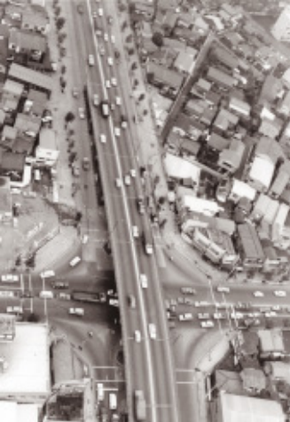
環状7号線高円寺陸橋(1969年)
