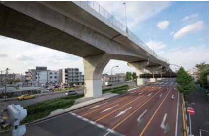
国道17号線(新大宮バイパス)、高架が首都高速5号池袋線
