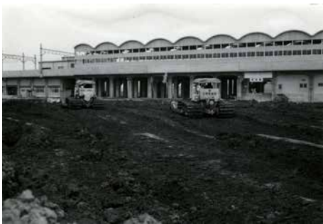
高島平駅(志村駅)前の工事着工(昭和44年)
