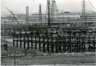
高島平団地造成中(昭和45年)
