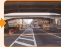
踏切除去後の道路の盤下げ工事(JR中央線 天文台踏切)
