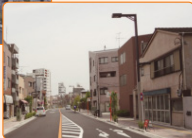
無電柱化により安全で快適な街並みを実現(墨田区桜橋通り)
