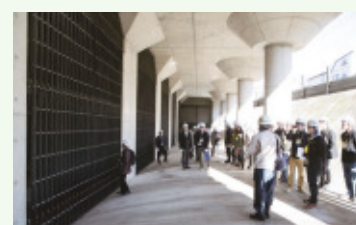
調節池の流入口内部。
