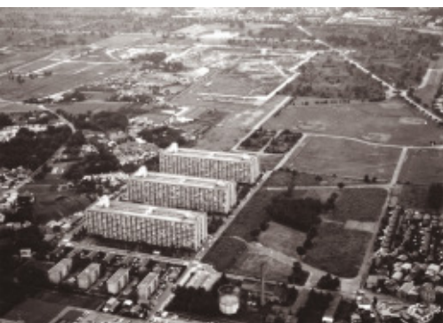
光が丘公園(地下上下水道施設工事) 昭和52年頃
