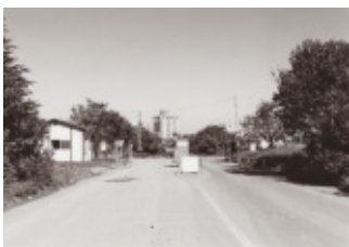
光が丘公園建設工事事務所(左側)付近から東方を望む 昭和52年頃
