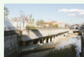
平成14年7月に完成。調節池の上部は公園になっており、区民の憩いの場となっています。
