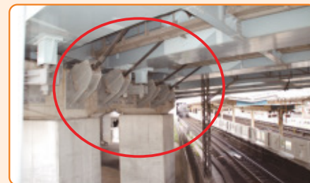
緊急輸送道路等の橋梁の耐震化
