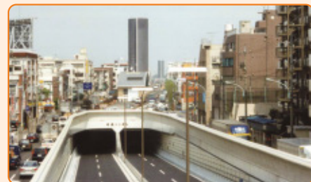
環状八号線 井荻トンネル
