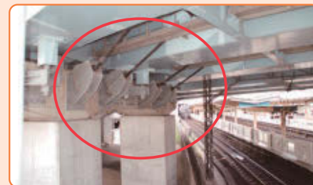
緊急輸送道路等の橋梁の耐震化
