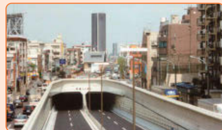
環状八号線 井荻トンネル
