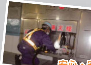
消火栓の点検
