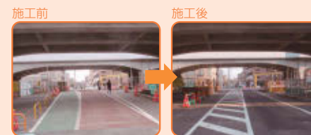
施工前 施工後 踏切除去後の道路の盤下げ工事(JR中央線 天文台踏切)
