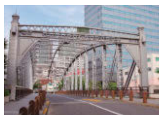
旧両国橋の一部が移設された中央区亀島川の南高橋
