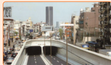
環状八号線 井荻トンネル
