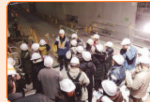
首都高速中央環状品川線 大井北立抗工事現場
