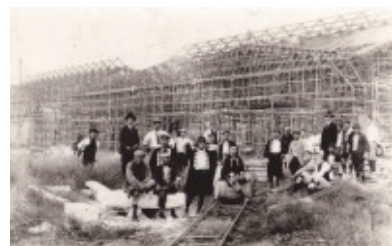
立川飛行場建設風景
