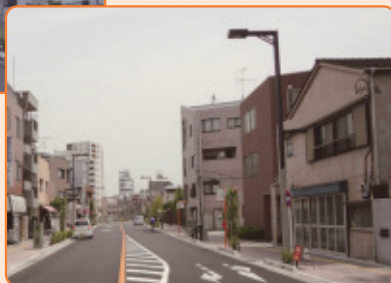
無電柱化により安全で快適な街並みを実現(墨田区桜橋通り)
