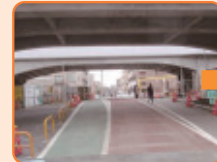
踏切除去後の道路の盤下げ工事(JR中央線 天文台踏切)
