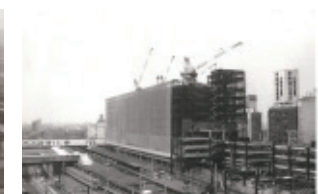
立川駅ビル 建設風景
