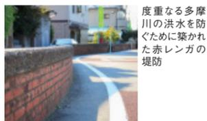
度重なる多摩川の洪水を防ぐために築かれた赤レンガの堤防
