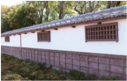
修景土塀 周辺の景観向上の一環として、既存の壁を生かしながら江戸の景観を模した壁の設置
