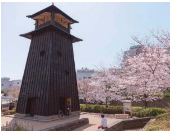
高さ15.5メートルの火の見櫓
