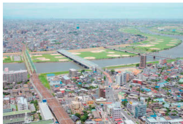
江戸川にかかる3つの橋梁。左からJR総武本線、市川橋、京成本線
