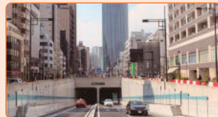
環状二号线 築地虎ノ門トンネル
