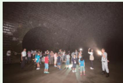
環状七号線の地下にシールド工法で掘られたトンネル。延長約4.5kmという巨大な地下調節池です。
