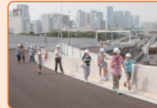
首都高速中央環状品川線工事現場見学ツアー
