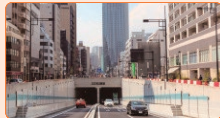
環状二号线 築地虎ノ門トンネル
