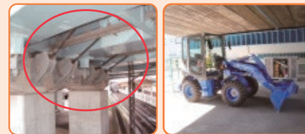
緊急輸送道路等の橋梁の耐震化 道路防災ステーション
