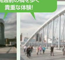
橋名も刻まれています。ハープのようなアーチ部分は外側に傾いているのがよくわかります。
