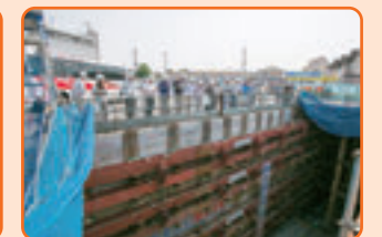
府中所沢線道路工事現場見学ツアー
