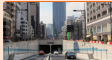
環状二号线 築地虎ノ門トンネル
