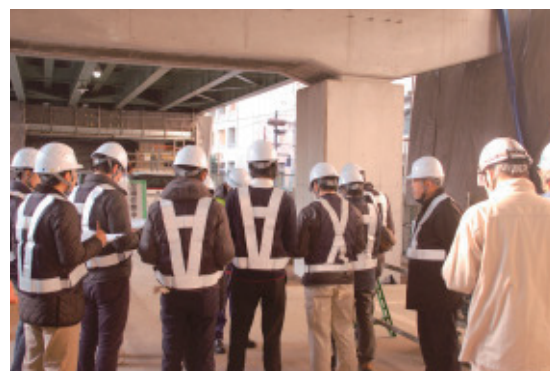
橋梁点検の様子
