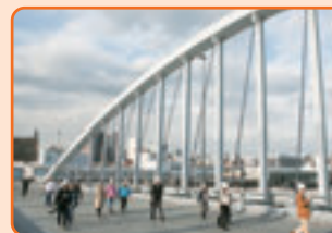
築地大橋及び勝どき陸橋工事現場見学ツアー
