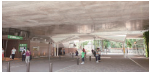
JR中央線の高架化によって武蔵境駅の南北が一つに
