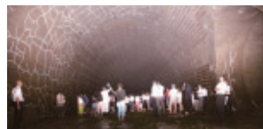
環七の地下にシールド工法で掘られたトンネル。延長約4.5kmという巨大な地下調節池です。
