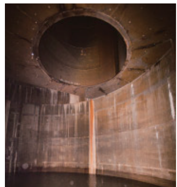
地上の取水口から地下トンネルへ水を導く縦穴。騒音や振動を抑えるために「ドロップシャフト」と呼ばれる渦を巻きながら水を落とす仕組みになっています。
