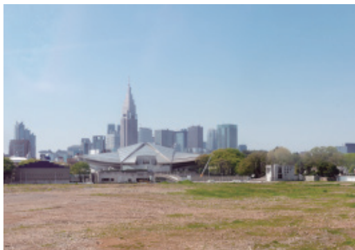
旧国立競技場解体跡地と東京体育館(平成28年春)
