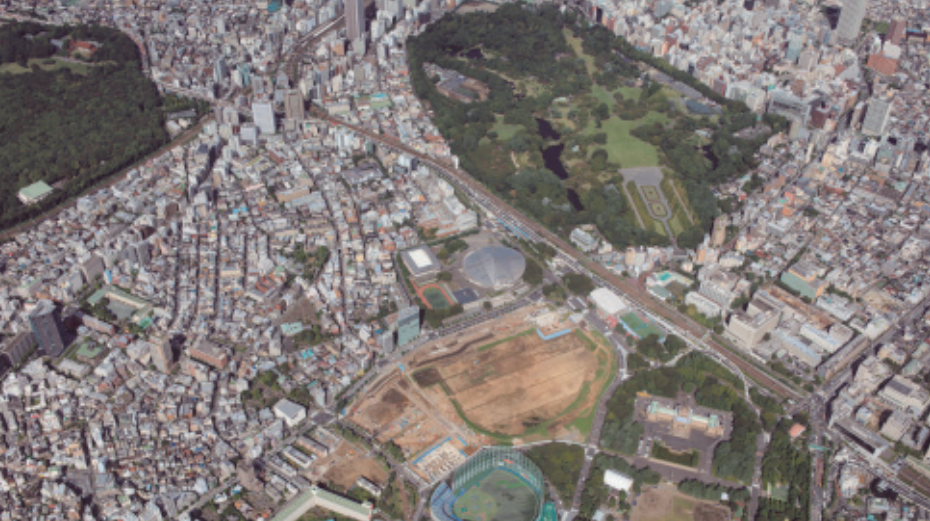
新国立競技場建設用地上空
