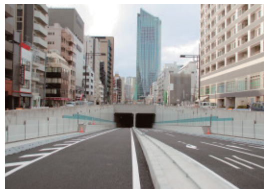
環状二号線築地虎ノ門トンネル
