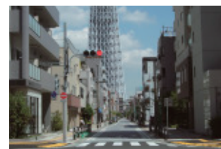
無電柱化施工後（墨田区 タワービュー通り）
