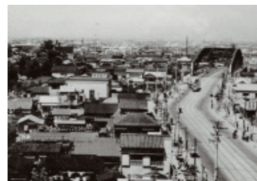
千住大橋、国道4号(昭和29年(1954))
