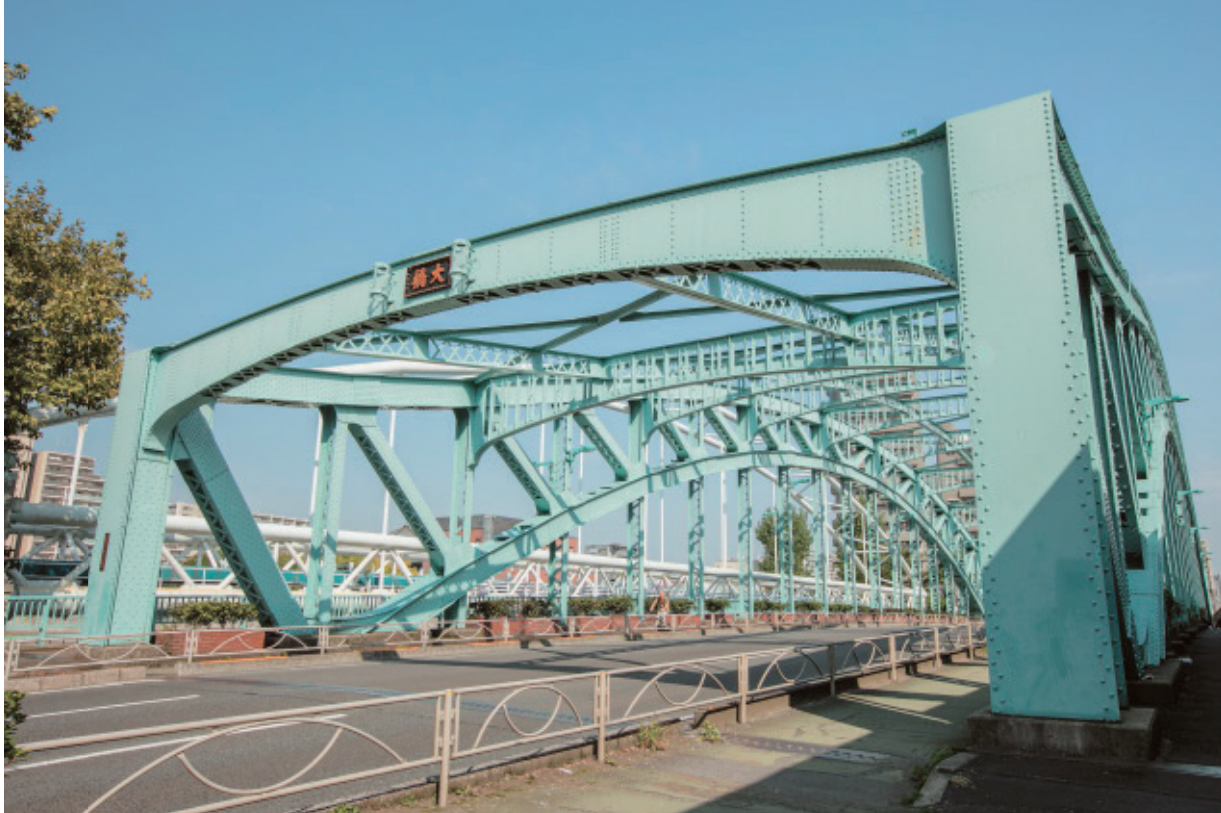
隅田川に最初に架けられた橋・千住大橋。現在の橋は昭和2年(1927)に竣工(足立区側から)
