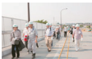
JR 中央線オーバースタジアム工事現場を見学
