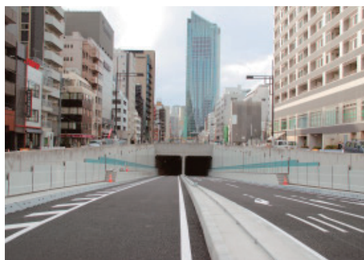
環状二号線築地虎ノ門トンネル
