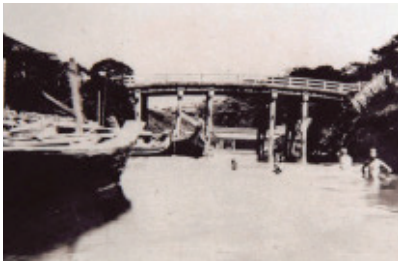
明治7年（1874）頃の水道橋 ©文京ふるさと資料館
