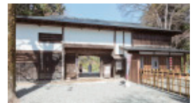
旧本多家住宅長屋門
