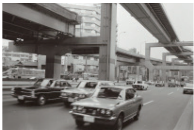
玉川通り立体交差 昭和46年(1971)
