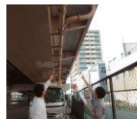
道路高架下の点検
