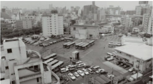
大橋ジャンクションの建設予定地 平成9年(1997)
