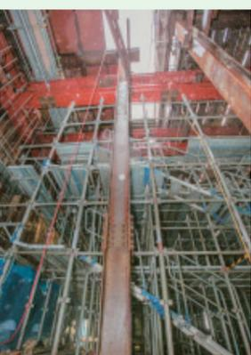
Hの文字は都電のレールを支えていた仮受杭を切断した跡。
