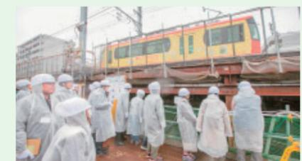
間近に走る都電荒川線は大迫力！工事中は頑丈な鋼材で仮受けしています。
