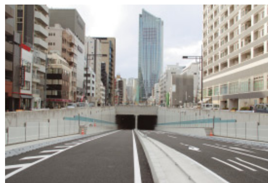
環状二号線築地虎ノ門トンネル
