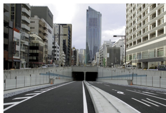
環状二号線築地虎ノ門トンネル
