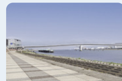
多摩川スカイブリッジ
