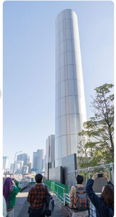
土地有効活用のため、トンネルの上に建てられた築地換気所。地上3階、地下3階の構造になっています。
