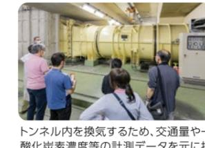
トンネル内を換気するため、交通量や一酸化炭素濃度等の計測データを元に排風機とジェットファンを適正に運転
