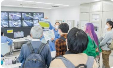
トンネル内の情報をCCTVモニター等で24時間体制で監視する監視室。モニター毎に区間を決めて、監視するカメラは順次切り替えられています。
