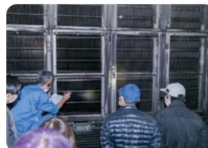
トンネル内を走行する車の排気ガスに含まれる煤塵(SPM)を除去
