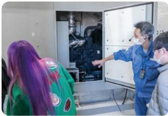
電力会社からの電力供給が停止した場合、重要な施設へ電気を送るディーゼル発電機。一般住宅なら100軒分を賄える500kVAで、24時間運転できる能力があります。
