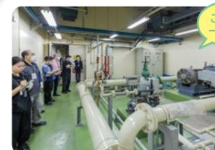
360トンの水を常時蓄える消火水槽を設置。トンネル内の火災時、消火ポンプを起動し、水を消火栓・水噴霧設備等に供給
