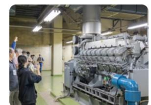
停電に備えて設置しているディーゼル発電機。すぐ起動できるように常に温まっています。
