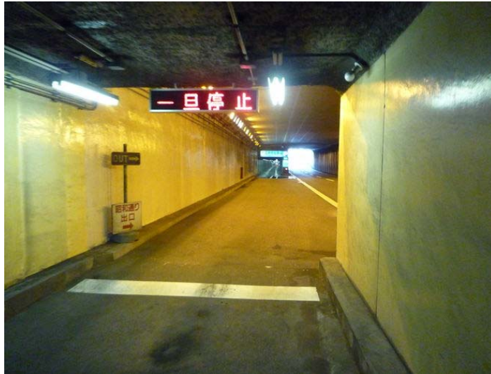
写真-3-3-1 貨物車進入路の出口（モデル駐車場）
