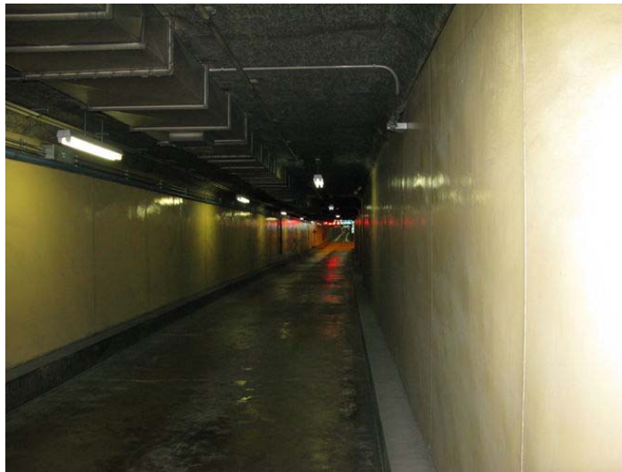
写真-3-3-2 貨物車進入路の屈曲部と通路（モデル駐車場）
