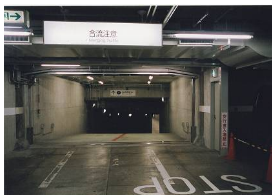
写真-2-2-20 地下駐車場と地下通路を結ぶ進入路（丸の内）
