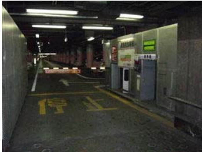
写真-3-3-3 貨物車通路の出入口（モデル駐車場）
