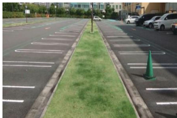
車止め②（物理的に車室を分離）
