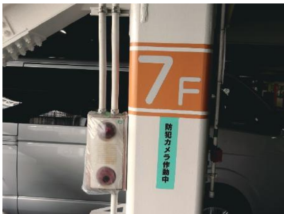
駐車場内の柱
