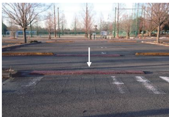
速度低下を促すハンプの設置事例（彩湖公園：埼玉県）
