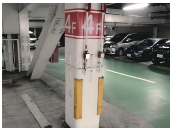
駐車場内の柱（保護材）
