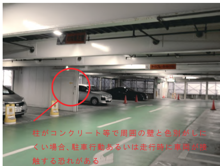
図 4-45 柱の視認性の向上と躯体の保護
