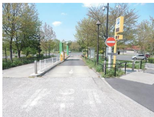
平面駐車場出入口
