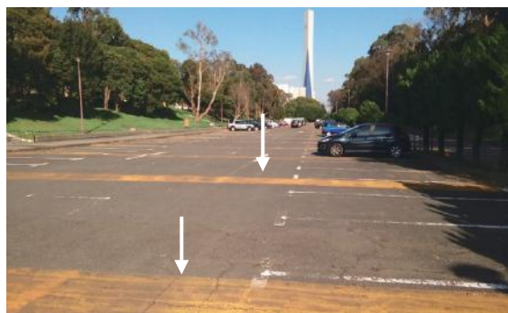
速度低下を促すハンプの設置事例（夢の島公園：東京）
