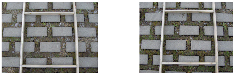
図 108. 霜柱による被害(再掲)
