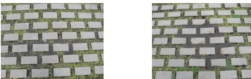
図 109. エンジン廃熱による枯損(再掲)
