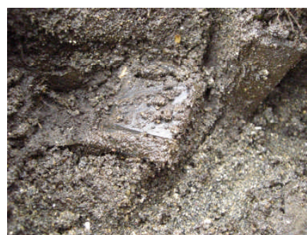
図 25. スペーサーの破損
