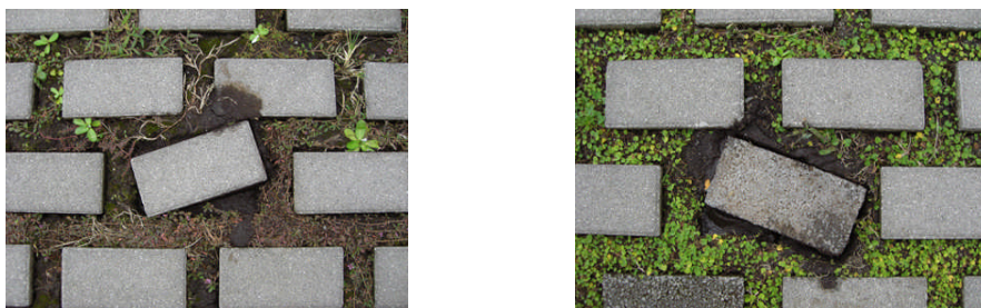
図 107. タイヤの切り返しによる破損(再掲)
