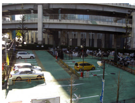
図 4. ガーデンパーク六本木 (外周、分離帯緑化と全面遮熱性舗装)
