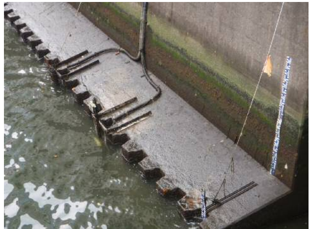
写真-1 設置した水位計・流速計
