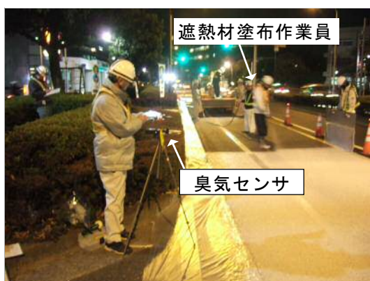
写真-5 施工時臭気測定状況
